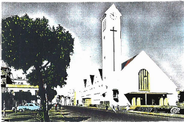
MAARIF - EGLISE St ANTOINE DE PADOUÉ Rue du Jura
